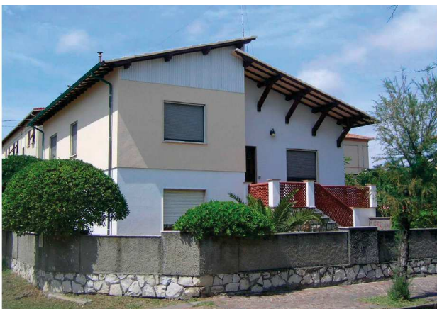
Edificio via del Popolo angolo via Volta
