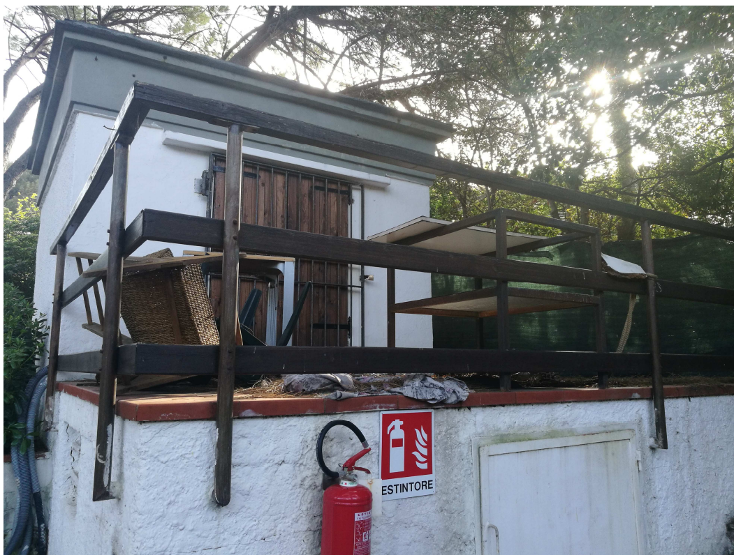
Fig. 7 – Locale deposito con pozzo
