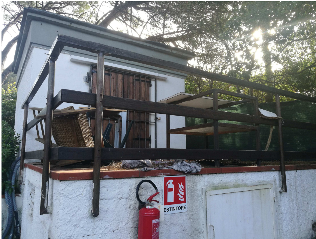
Fig. 7 – Locale deposito con pozzo
