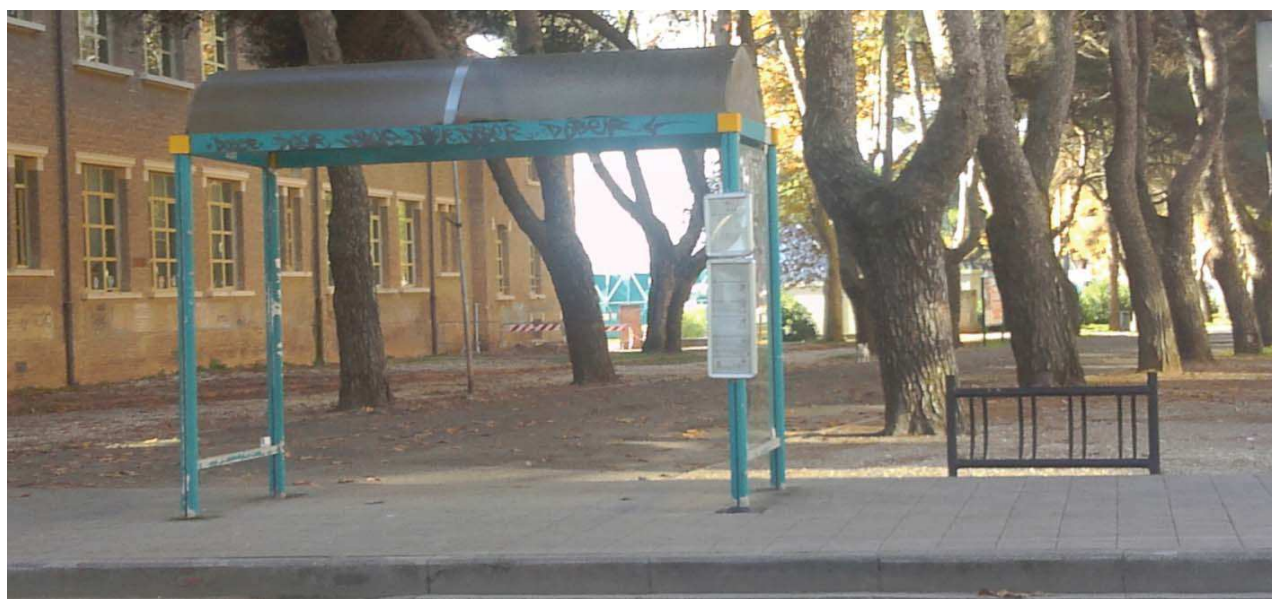
Figura 44: fermata TPL località Rosignano Solvay in stato di evidente degrado
