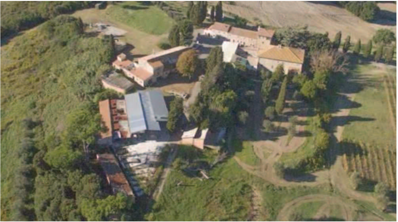
Foto aerea degli elementi di degrado
