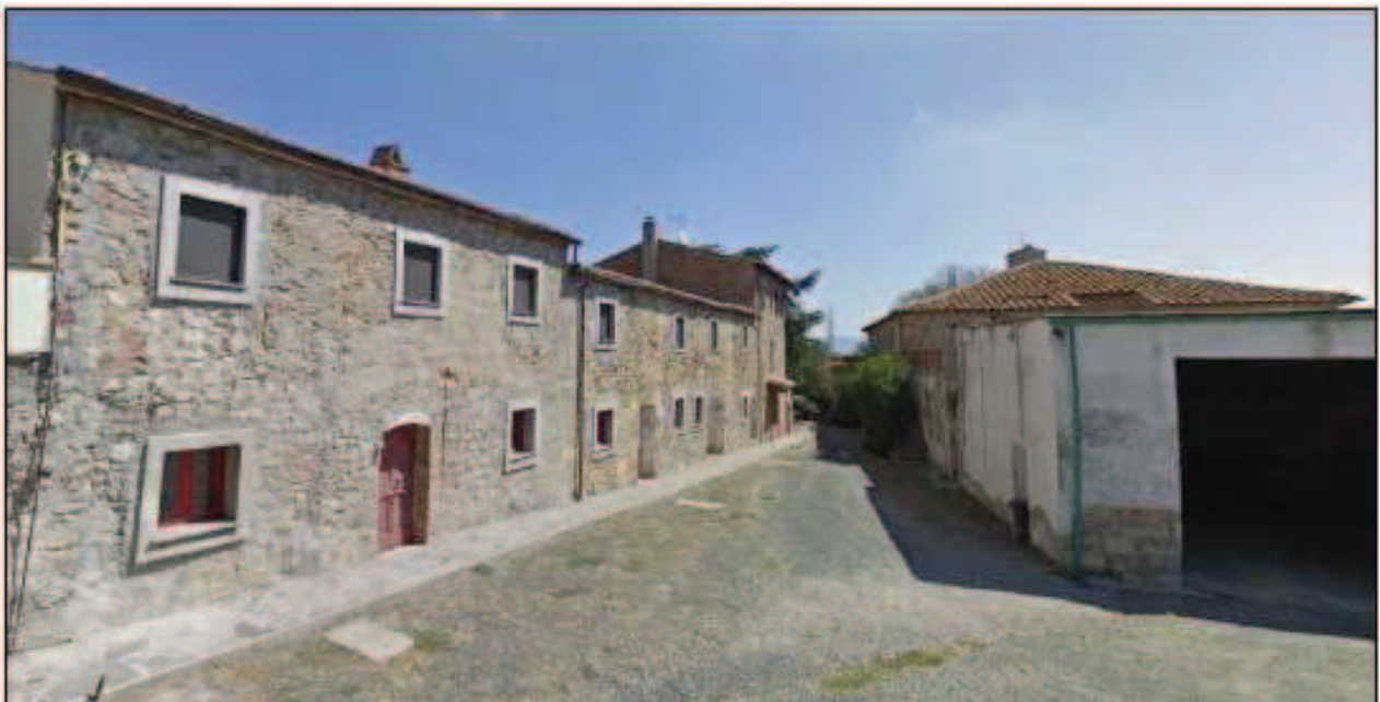
Passaggio tra edificio A e B
