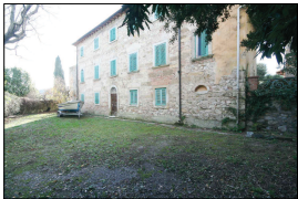
Villa Paltratico (edificio B) - prospetto est
