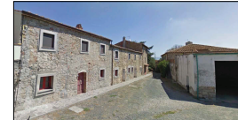
Passaggio tra edificio A e B
