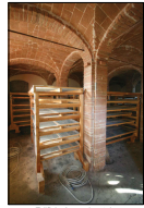
Edificio A - essiccatoio
