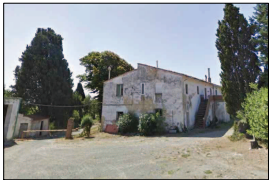
Edificio C - prospetto nord
