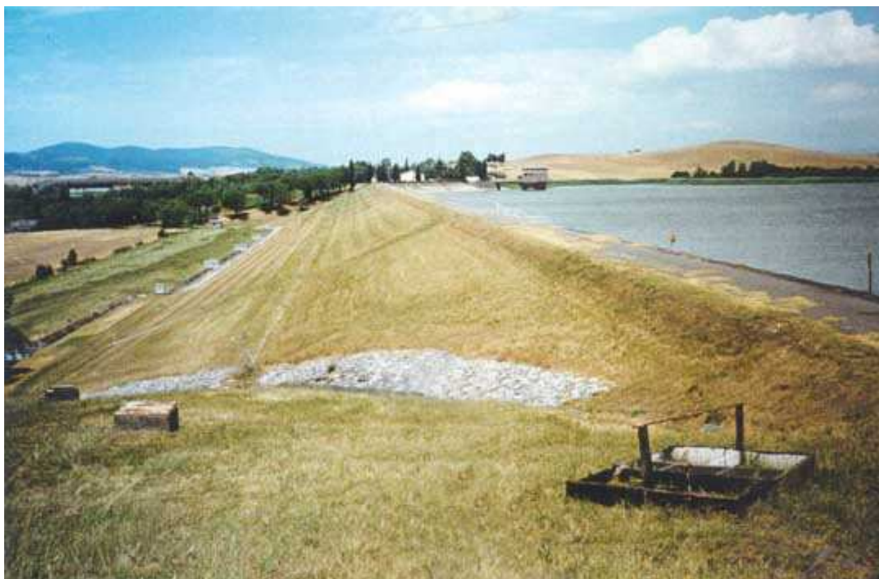
Vista panoramica del coronamento e del paramento di valle
