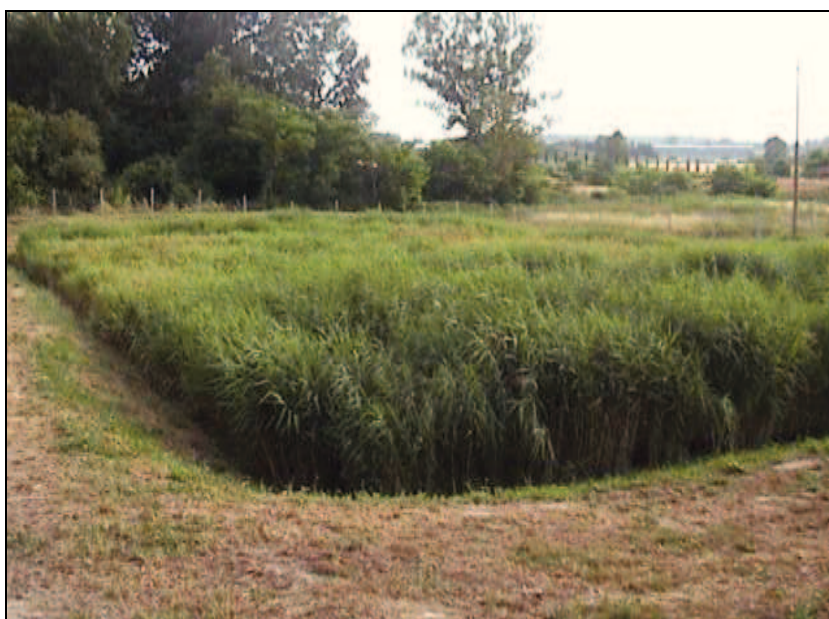
Figura 8 – Sistema di fitodepurazione al servizio dell'Azienda Vitivinicola Tenuta dell'Ornellaia (Castagneto Carducci – LI)
