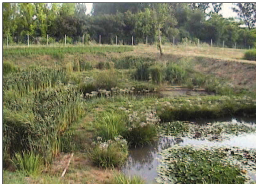
Figura 9 – Sistema di fitodepurazione per il trattamento del percolato della discarica di Taglietto, Comune Villadose (RO)
