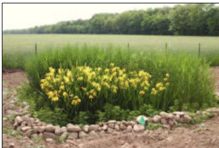
Figura 6 – Sistemi di fitodepurazione a servizio di una civile abitazione (10 AE)
