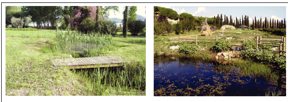
Figura 3.8 – Sistemi a flusso libero: a sinistra impianto post-trattamento Isola di Polvere, Lago Trasimeno (PG), a destra impianto per post-trattamento ed accumulo, Loc. Rispecchia (GR)
