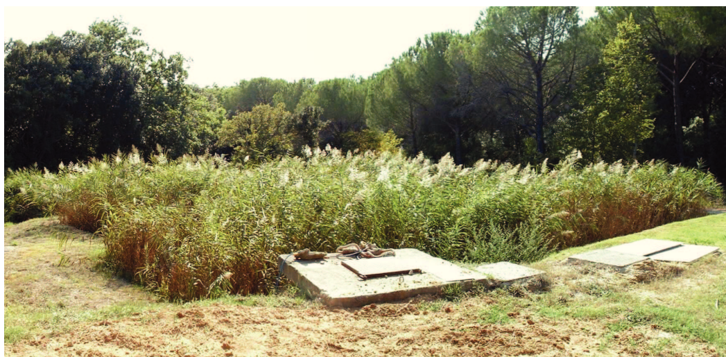
Figura 3.2 – Sistema a flusso sommerso verticale (Azienda Vitivinicola Tenuta dell'Ornellaia – LI)
