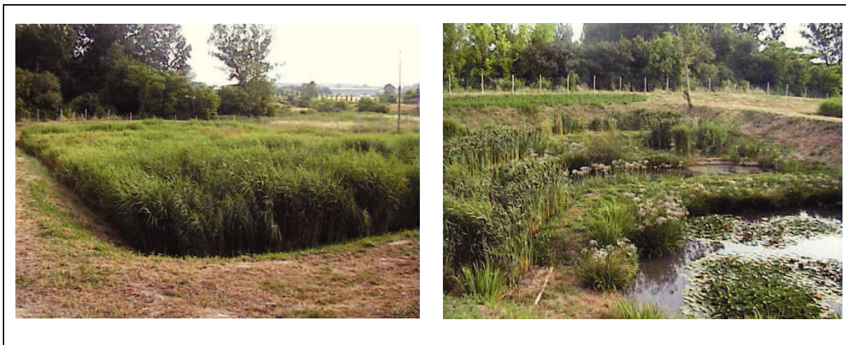
Figura 3.1 – A sinistra sistema a flusso sommerso orizzontale e a destra sistema a flusso libero (Cantina Cecchi & Figli, Castellina in Chianti – SI)
