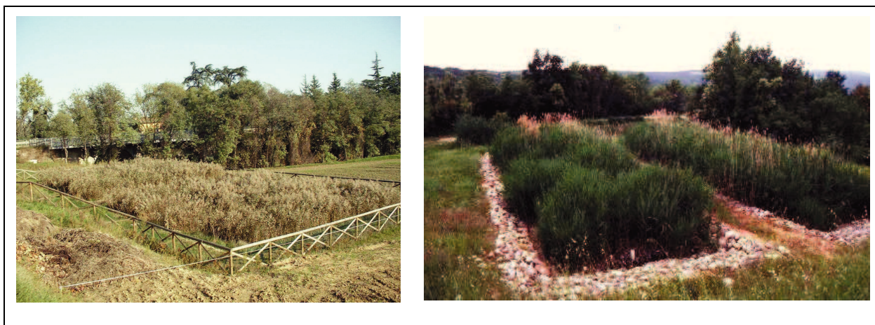
Figura 3.4 – Sistemi a flusso sommerso orizzontale: a sinistra sistema di trattamento di reflui urbani (200 AE) nel Comune di Dozza Imolese (BO), a destra impianto (60 AE) a servizio dell'Azienda agrituristica Tenuta di Spannocchia (SI)
