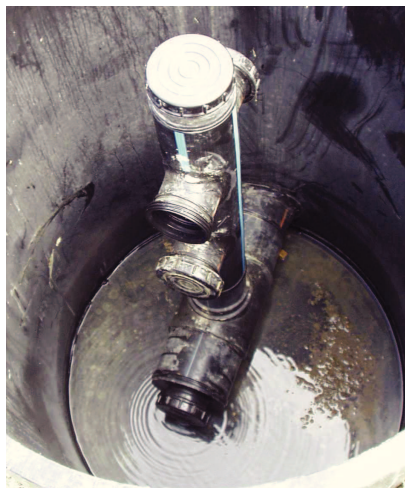
Figura 3.14 – Pozzetto con dispositivo di regolazione.
