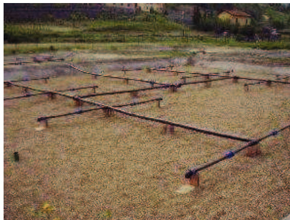
Figura 3.16 –Sistemi di fitodepurazione a flusso verticale: particolare del sistema di alimentazione.
