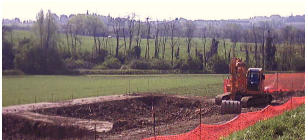
Figura 3.10 – Operazioni di scavo e movimento terra per la creazione delle vasche.
