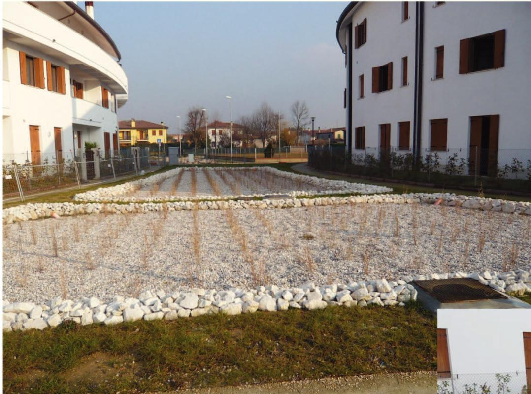
Le acque grigie trattate e recuperate sono circa 15 mc/g e vengono trattate in due differenti sistemi di fitodepurazione a flusso sommerso orizzontale, per una superficie utile totale di 232 mq
