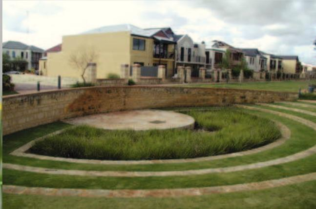
**Raccolta delle piovane dai tetti** in depositi interrati e successivo riuso previo trattamento su filtro a sabbia vegetato o filtri in linea
