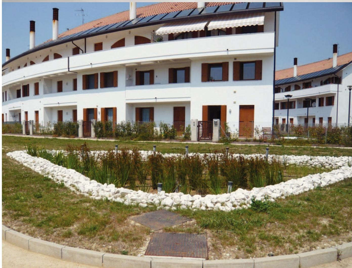
Le acque meteoriche dei tetti in un sistema di filtrazione vegetato di superficie utile 50 mq e accumulate in serbatoi di 170 mc
