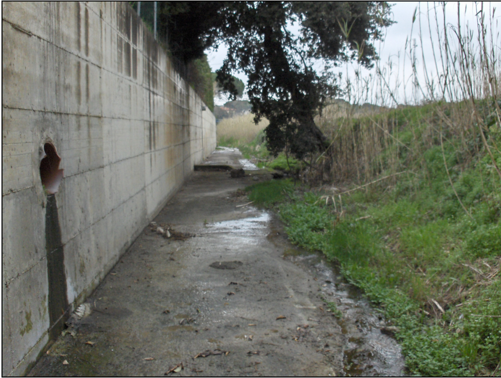
Foto n° 1 Sez. su Botro Jurco a monte
