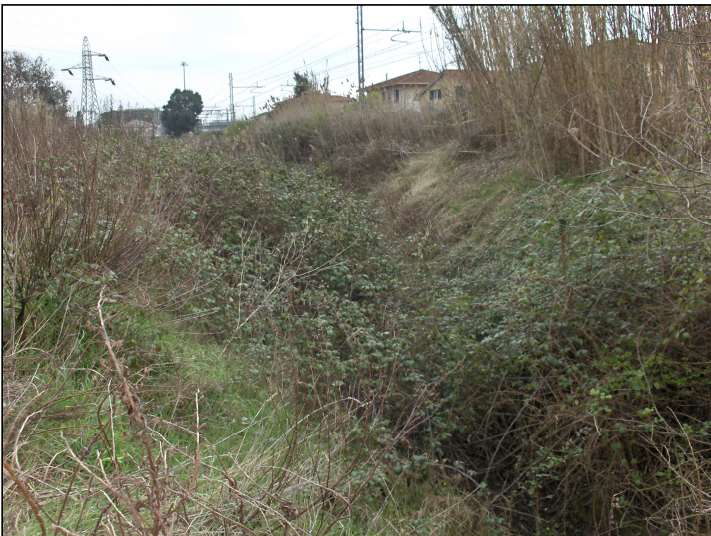
Foto n° 4 Sez. su fosso lungo la ferrovia
