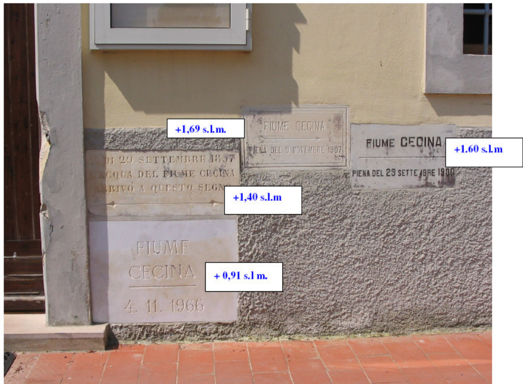
Foto 1- Quote del livello di allagamento rilevati presso l'impianto idrovoro della Mazzanta
