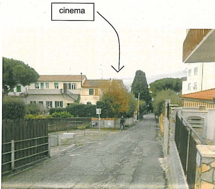
2) Vista dal ponte sulla ferrovia di via della Ragnaia
